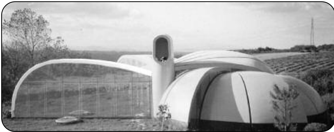
Coques moulées en résine armée de verre (maison de Martine Jovine et Pierre Colleu).
