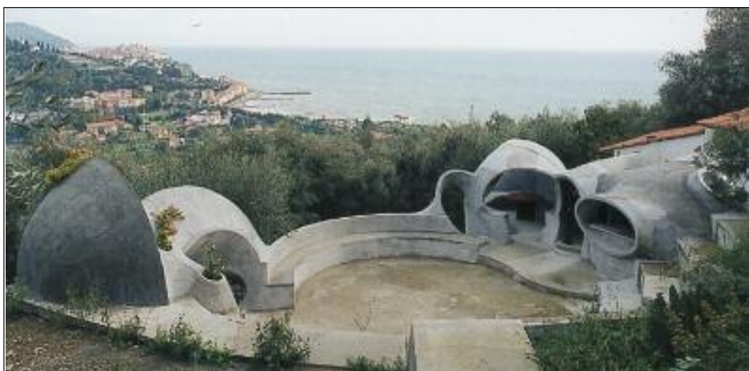
Une partie des coques réalisées
