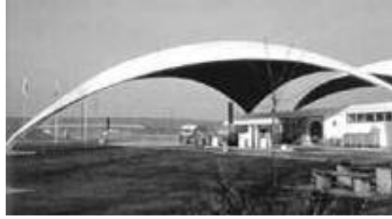
Figure 6 : H. Isler, Couverture d'une station-service.
