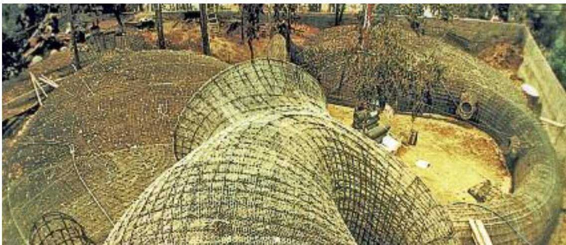
Le chantier au stade du ferrailage revêtu du grillage qui sert de coffrage perdu. (Architecte Javier Senosian)
